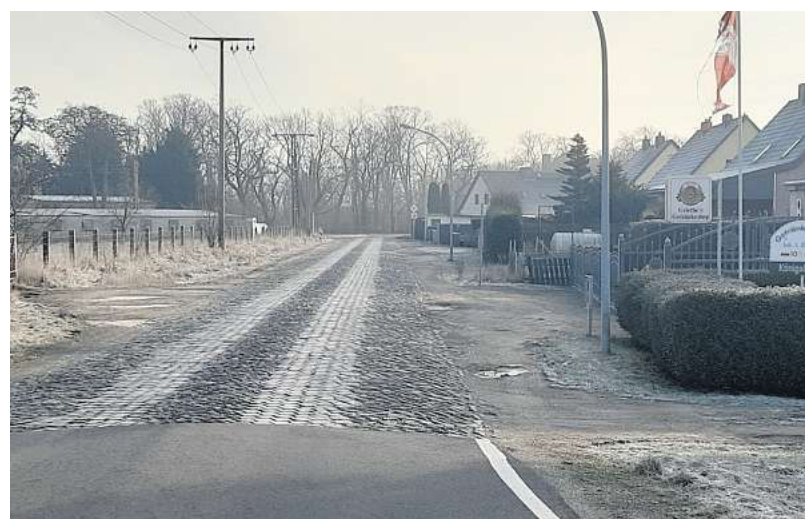
Die S25-Ortsdurchfahrt Packisch soll 2024 ausgebaut werden. FOTO: NICO WENDT
