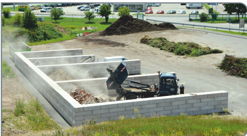
Zwischenlager für bestimmte Bauabfälle auf dem Betriebshof Torgau
